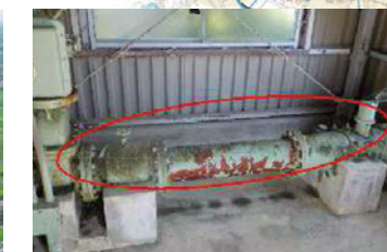
熊野神社裏地下水機場(地下水ポンプ、配管類、ポンプ操作盤等更新)
