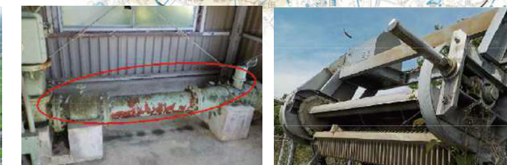
熊野神社裏地下水機場(地下水ポンプ、配管類、ポンプ操作盤等更新)
