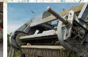
今井揚水機場(除塵機更新)
