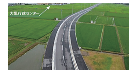
完成箇所(東松山市方面を望む)
