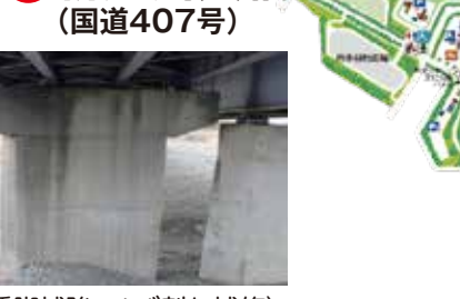
耐震(橋脚補強、ひび割れ補修)
