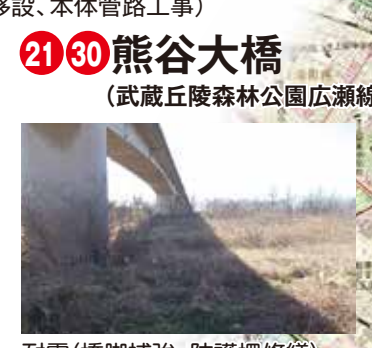
耐震(橋脚補強、防護柵修繕)
