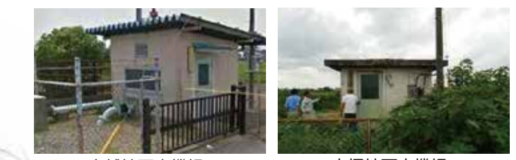
水越地下水機場 大塚地下水機場
