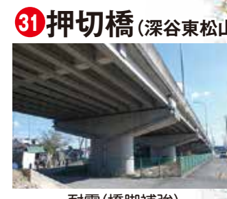
耐震(橋脚補強)
